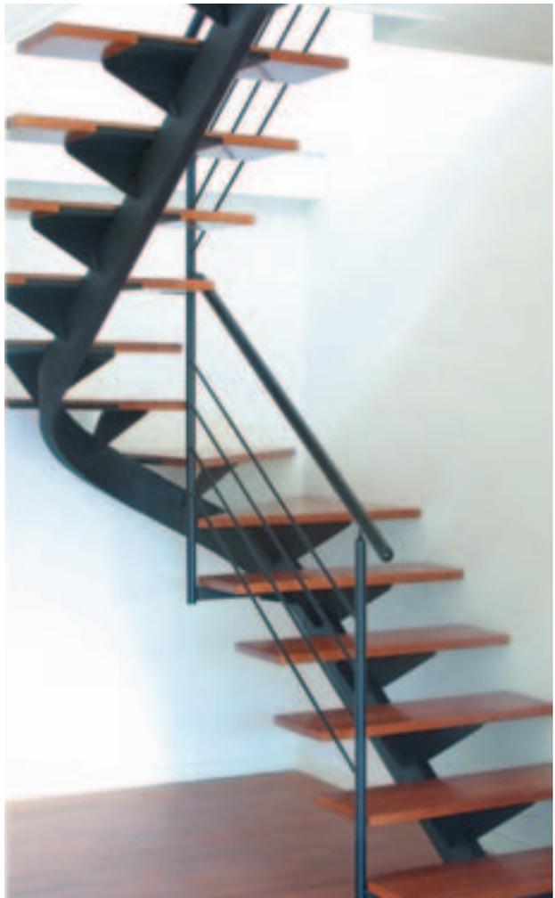
Vista inferior de zanca de escalera compensada, instalada en Vivienda Particular.
