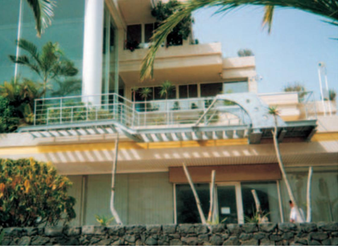
Escalera de Tramo basculante con mecanismo hidráulico instalada en Apartamentos.
